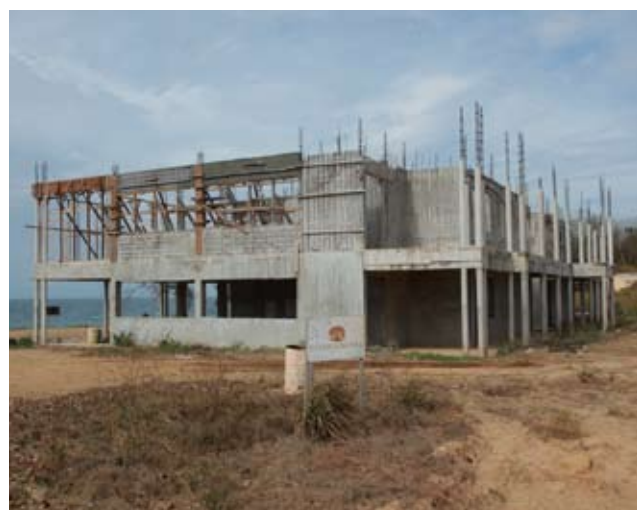
Hotel en construcción.
