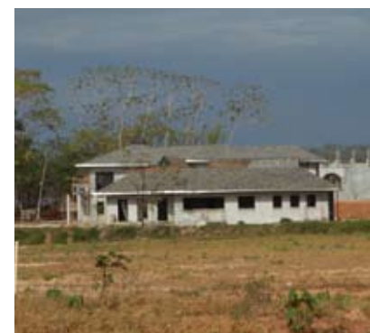
Residencias de la primera etapa.
