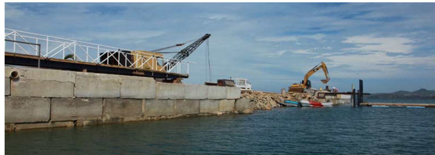
Adelantos en la construcción de la marina.
